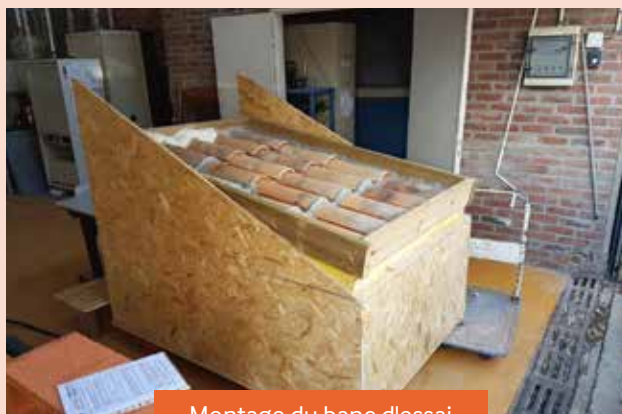
Montage du banc d'essai SUPERHERO au CTMNC
